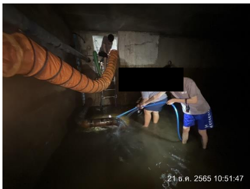
การทำความสะอาดถังสำรองน้ำใช้ ภาพที่ 2.2-5 (ต่อ) การบริหารจัดการระบบน้ำใช้
