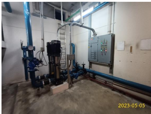
ฝาลังเก็บน้ำ และเครื่องจักรระบบน้ำใช้
