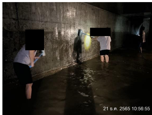
การทำความสะอาดถังสำรองน้ำใช้ ภาพที่ 2.2-5 (ต่อ) การบริหารจัดการระบบน้ำใช้
