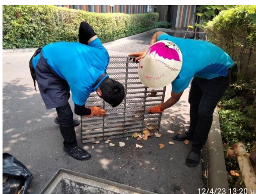
การตรวจสอบและดูแลท่อระบายน้ำ ภาพที่ 2.2-6 การบริหารจัดการระบบระบายน้ำ
