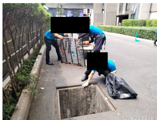
การตรวจสอบและดูแลท่อระบายน้ำ ภาพที่ 2.2-6 การบริหารจัดการระบบระบายน้ำ
