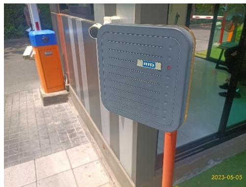
ระบบบัตรอิเล็กทรอนิกส์สำหรับเข้าออก
